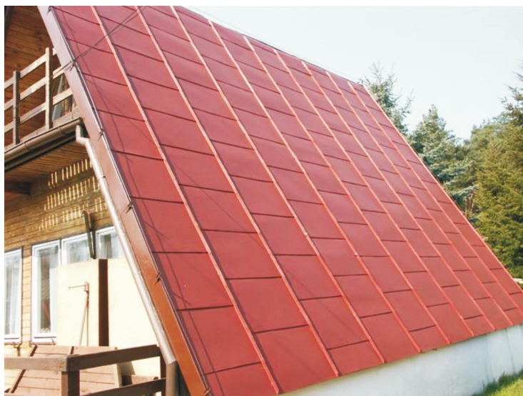
Rys. 1. Dach po renowacji Izofolem Dach.
