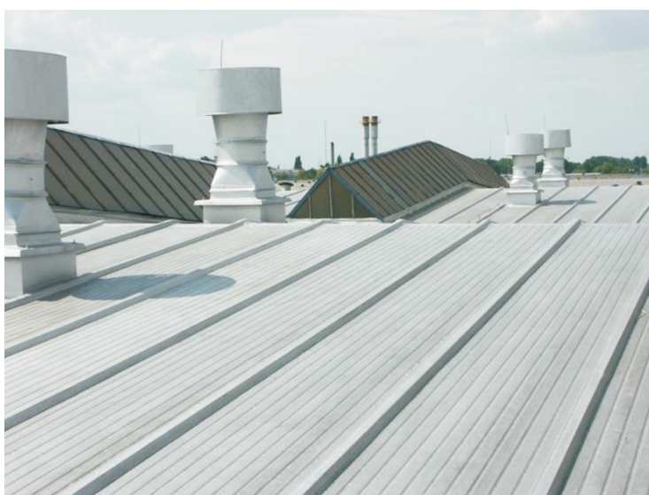
Rys. 3. Dach po renowacji Izobitem Alu.
