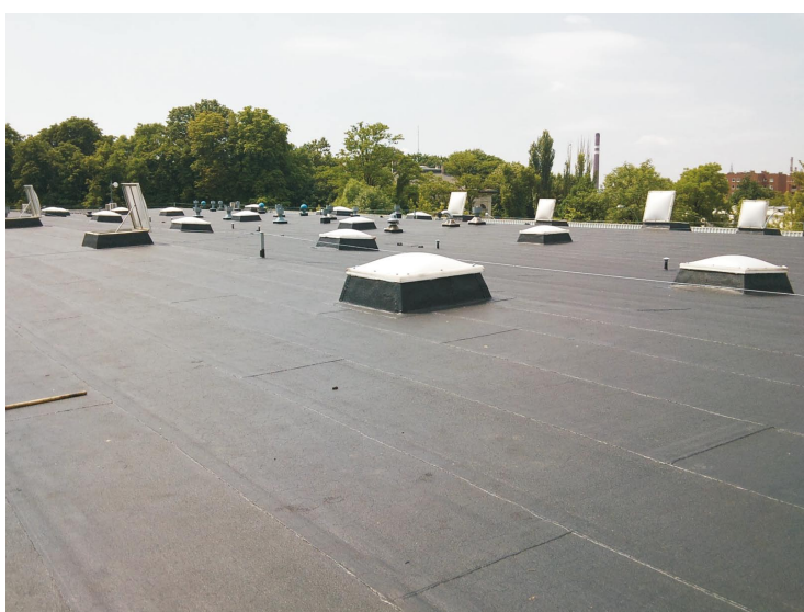
Rys. 2. Dach po renowacji Dysperbitem Dn.
